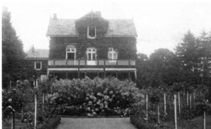
Die Gartenseite der Mutzenbecher-Villa um 1900: Ein großzügiger, trotzdem hanseatisch-bescheidener Landsitz. Vom Garten ist nichts mehr erhalten, Strukturen der Anlage aber noch erkennbar
