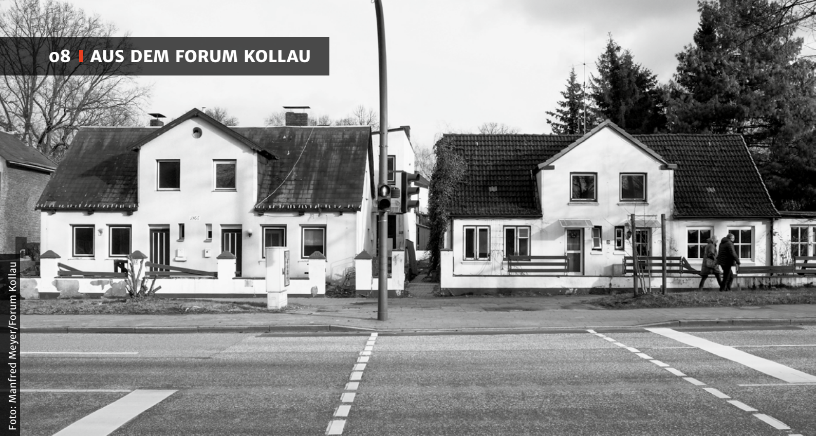
Die beiden historischen Häuser Nr. 17 und 19 im Januar 2018
